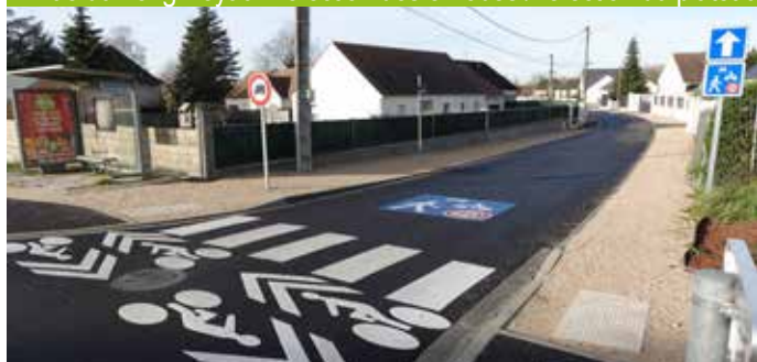
Rue du Long Boyau - réfection des enrobés / réfection du plateau Rue de Saint-André
