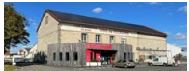
L'intégralité du toit de cette coopérative à Bléré (37) est couverte par des panneaux entièrement sombres.
