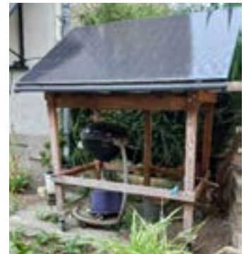
Panneaux thermiques formant une grande marquise au-dessus d'une baie et panneaux couvrant un barbecue.
