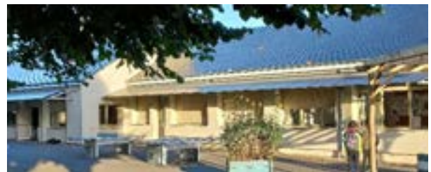
Panneaux photovoltaïques formant de grands brise-soleil le long des fenêtres d'une école à Amboise (37). Les panneaux permettent ainsi d'améliorer le confort d'été de l'équipement.
