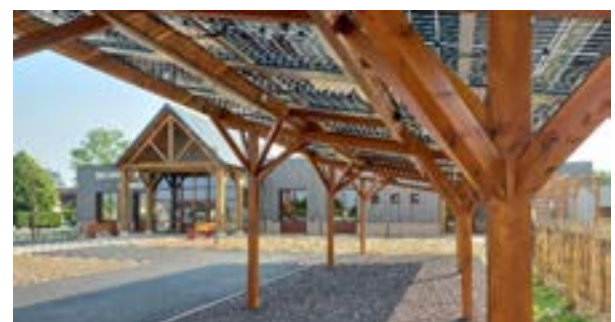
Ombrière photovoltaïque semi-transparente en bois sur le parking d'un commerce situé à la sortie du bourg de Maslives (41).
