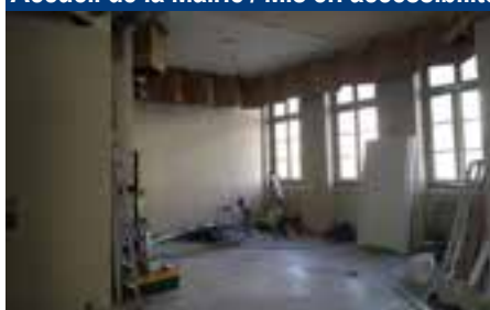
Démolition ancien accueil
