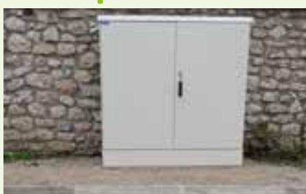
Les armoires de quartier sont posées
