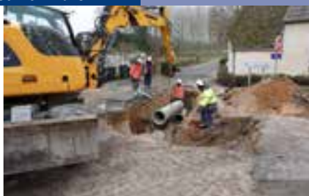
Réparation des canalisations d'eaux pluviales et d'eaux usées
