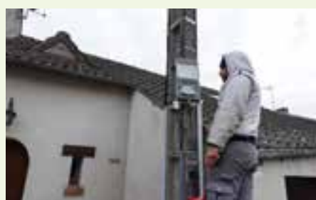
Pose des points de branchement s'appuyant sur l'infrastructure du réseau cuivre existant
