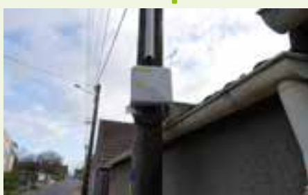
Pose des points de branchement s'appuyant sur l'infrastructure du réseau cuivre existant
