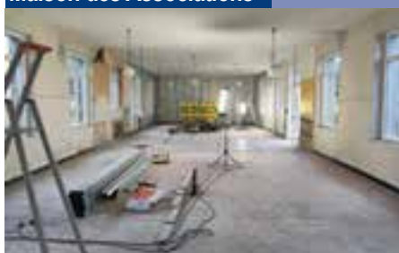
Démolition et préparation du chantier
