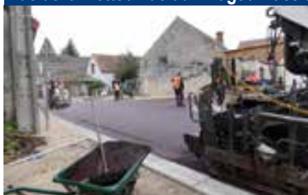
Mise en place de l'enrobé rouge
