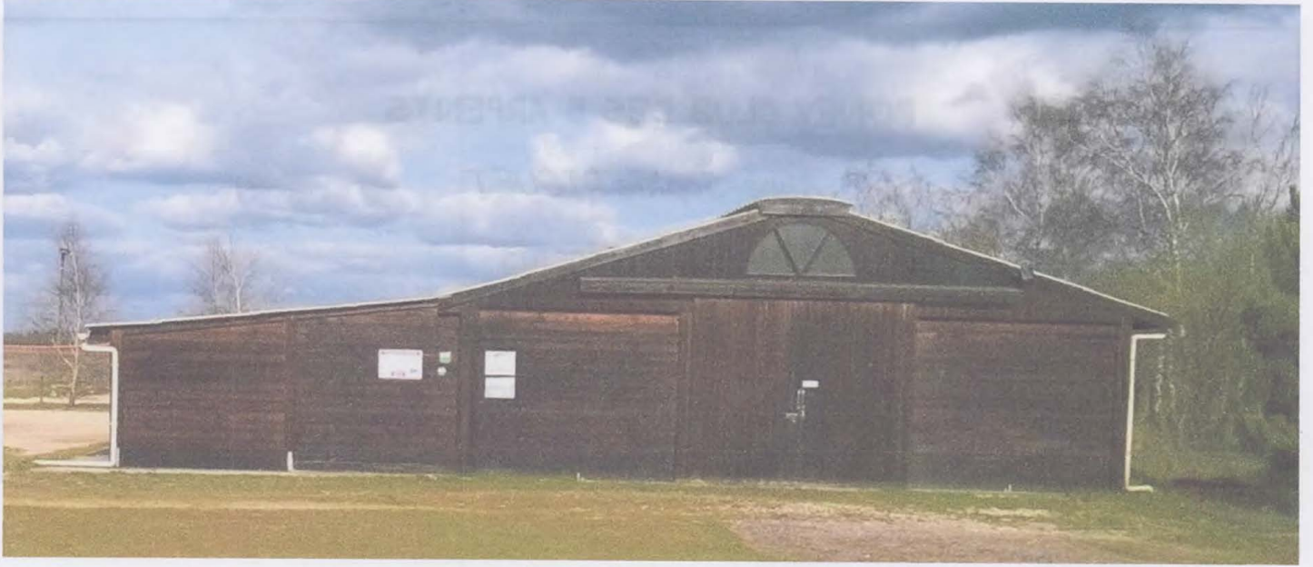
Bâtiment 1 : 210 m 2 > Ecuries
